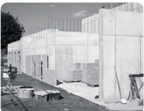
SV Wilhering - ein lange gehegter Wunsch wird realisiert. (Rohbauphase)
